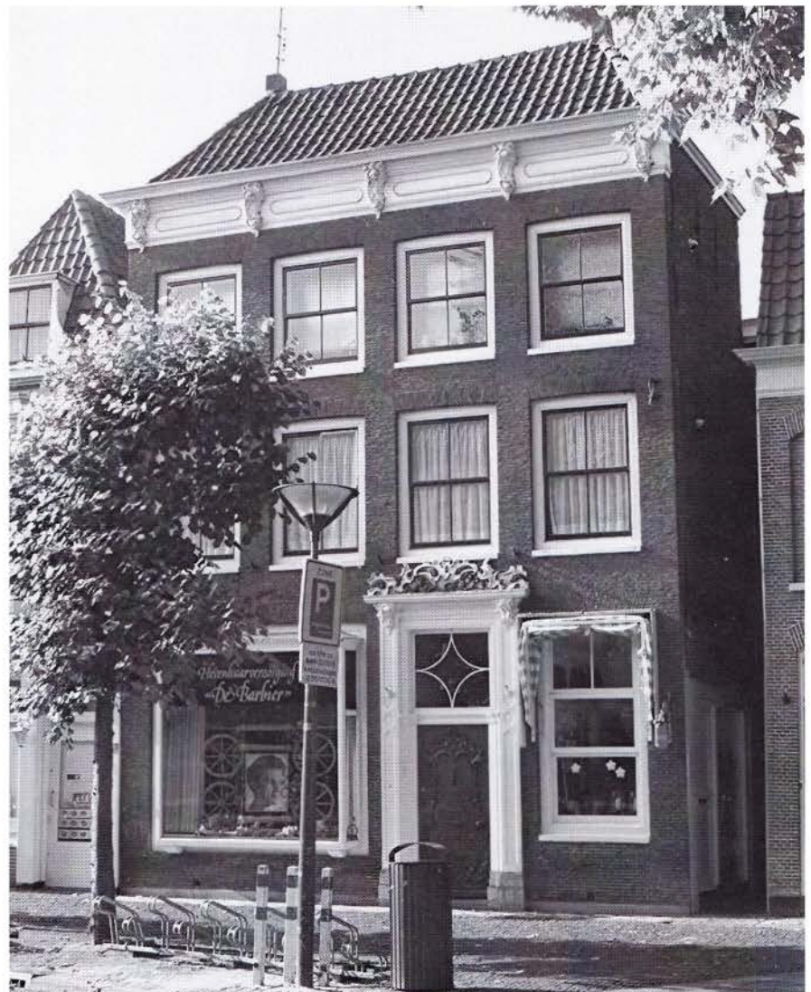
Ramen 35. Vier appartementen boven de winkelruimten: een onderscheiding waard!
