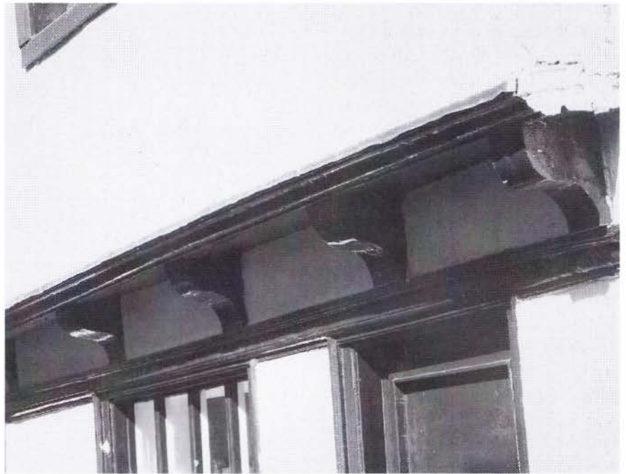
Kruisstraat 2. Eén van de schaarse zijgevels op overstek in Hoorn, voortgekomen uit de oorspronkelijke houtskeletbouw.
