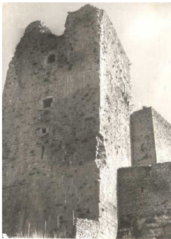
Figura 31 - Il Mastio, prima del restauro effettuato nel 1967
