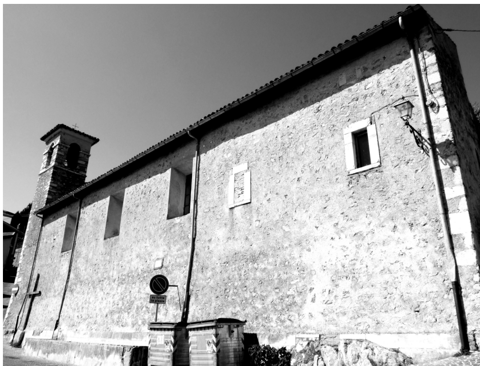
Fig. 33 Chiesa: parete esterna destra
