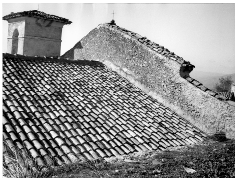
Fig. 24 tetto: particolare del timpano
