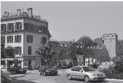
41 Ringmauer und Venner-Zyro-Turm
