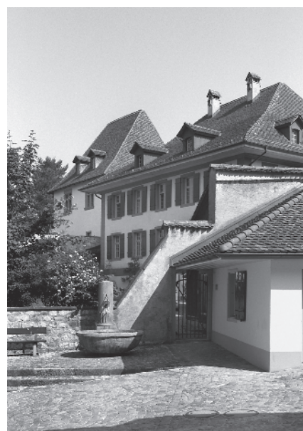
6 Abzugshaus und Oberes Pfarrhaus
