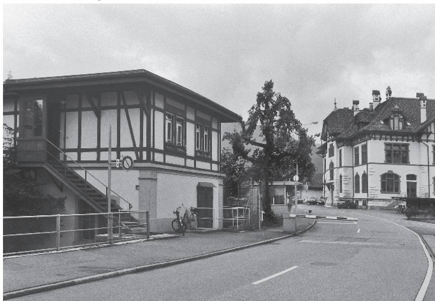
82 Ehem. Turbinenhaus und Restaurant «Aarestube»
