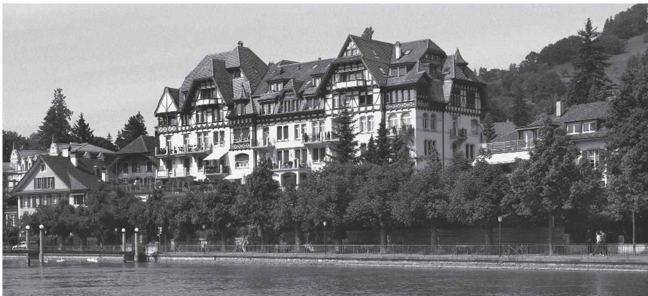
47 Aarequai, ehem. Hotel «Beau Rivage»
