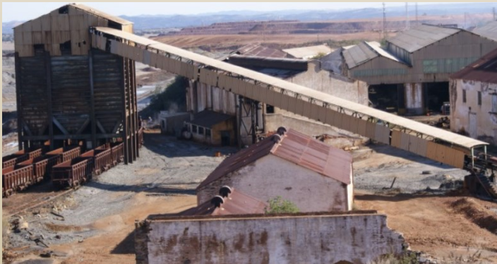
Rail loading facilities Instalaciones de carga del ferrocarril
