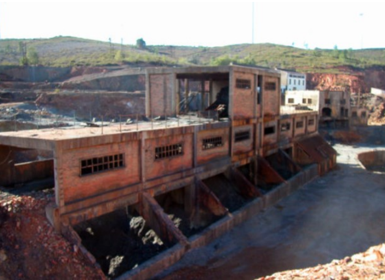
Installation remains in the Filón Norte Mine Resto de instalaciones en Filón Norte (espiadellabo.com)
