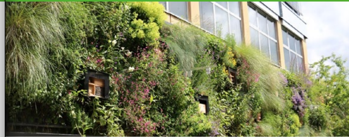
Fassadenbegrünungssystem – Universität Stuttgart (IABP)
