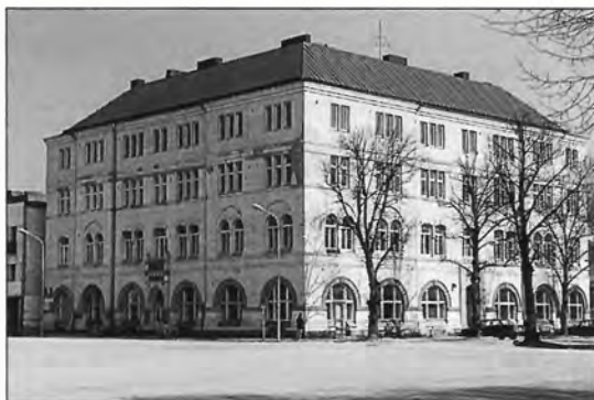
Bulevardin esikuntarakennus on myyty
