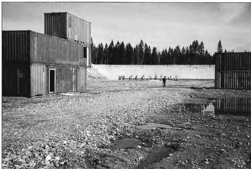
Erikoistilanneradan puolivalmiita kerrostaloja.
